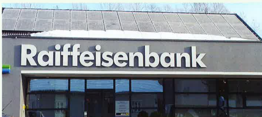
Photovoltaikanlage mit 28 kWp Leistung, 112 Module mit 155 m 2 Fläche
