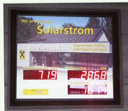
Monitoring und Visualisierung der PV-Anlage
