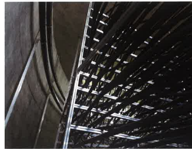
Die drei Wärmepumpen von Viessmann werden vom Eisspeicher als energieeffiziente Wärmequelle versorgt. Unten Blick in den Eisspeicher vor der Inbetriebnahme.
