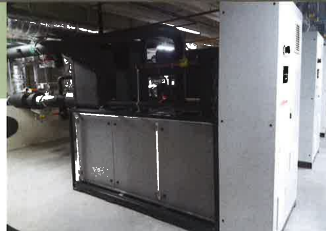
Die drei Wärmepumpen von Viessmann werden vom Eisspeicher als energieeffiziente Wärmequelle versorgt. Unten Blick in den Eisspeicher vor der Inbetriebnahme.
