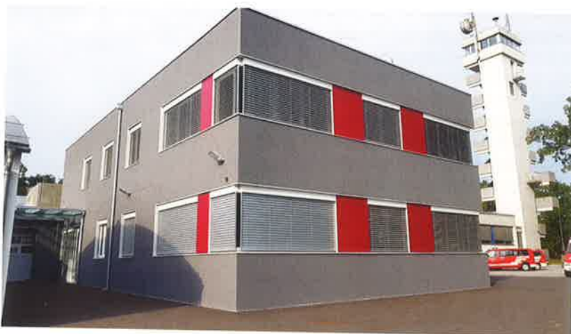
Der neue moderne Zubau der Feuerwehr- und Zivilschutzschule Lebring
