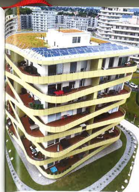
Bauteil GWS: Jedes der Häuser ist mit einer 10-kWp-PV-Anlage am Dach ausgestattet
