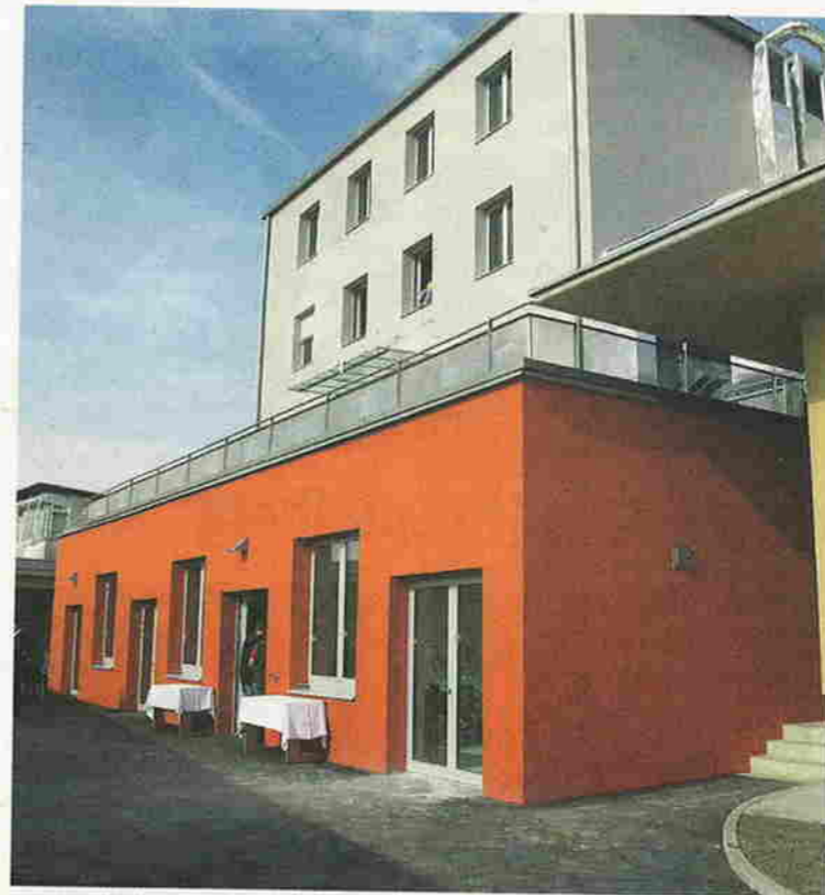
Der neu eröffnete Werkstättenzubau.
