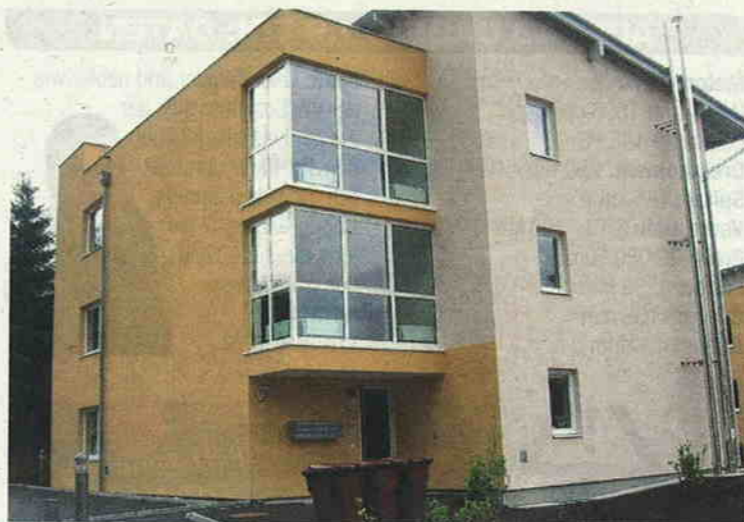
Die Seniorenwohnanlagen an der Salzstraße sind komfortabel ausgestattet.
