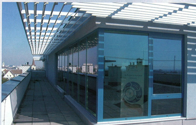
Hoch über den Dächern von Wr. Neustadt: die neue Niederlassung von TB Hammer
