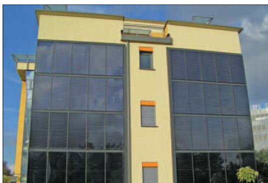
84 m 2 Sonnenkollektorfläche für Heizung und Warmwasseraufbereitung
