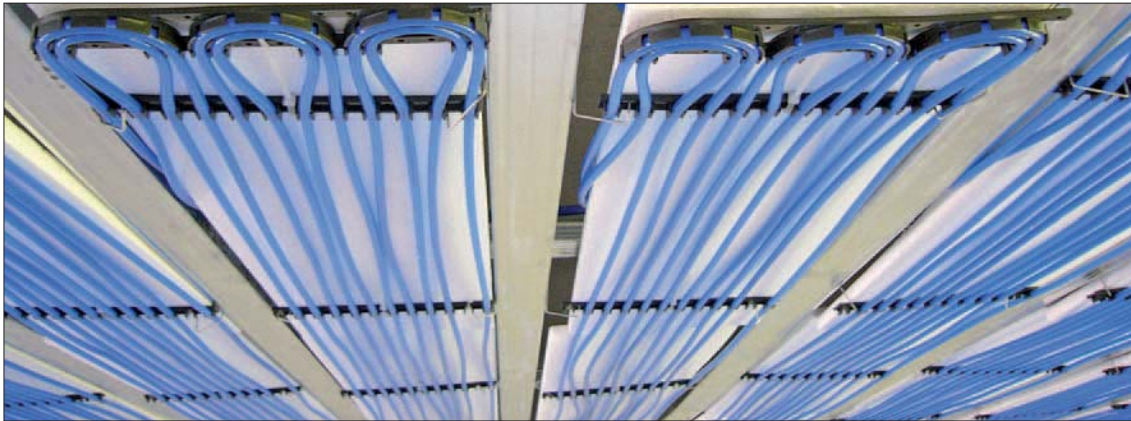
Heiz- und Kühldecke der Firma Universa Kunststofftechnik GmbH & Co KG
