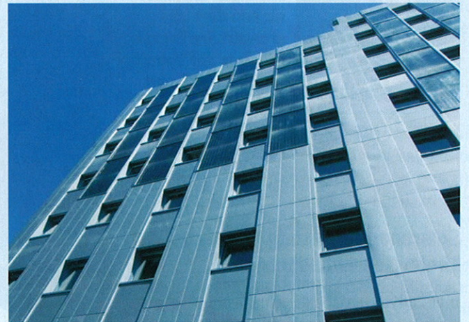
▲ Abbildung 2 Fassadenintegrierte Solaranlage am Friedrich-Schiller-Studentenheim, Graz
