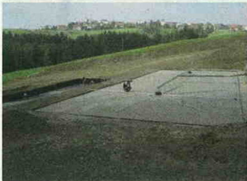
Die von der equadrat bau- und umweltplanung geplante Pflanzenkläranlage in Künberg/NÖ ist die größte Pflanzenkläranlage Österreichs und wird Ende 2006 in Betrieb gehen.
